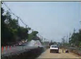
รูปที่ 8-10 การฉีดพ่นน้ำลงบนพื้นที่ก่อสร้างเพื่อลดผลกระทบจากผุ่นละออง
