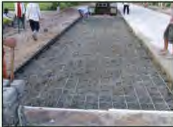
รูปที่ 6-57 เทคอนกรีตปรับเกลี่ยพร้อมวางเหล็กตะแกรงก่อนเทคอนกรีตทับบนเหล็ก
