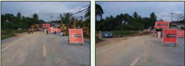
รูปที่ 5-19 แสดงการติดป้ายเตือนและไฟฟ้าแสงสว่างที่บริเวณก่อสร้าง
