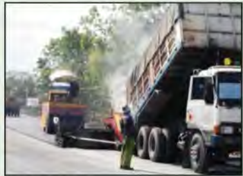
รูปที่ 6-27 รถบรรทุกส่วนผสมแอสฟัลต์คอนกรีต (Hot Mix) ต้องคลุมผ้าใบตลอดเวลา
