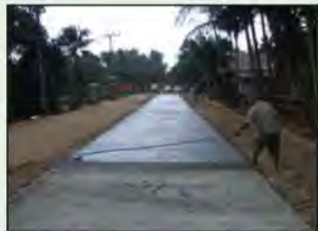
รูปที่ 6-60 แต่งสายที่ผิวหน้าขณะคอนกรีตยังหมาดอยู่
