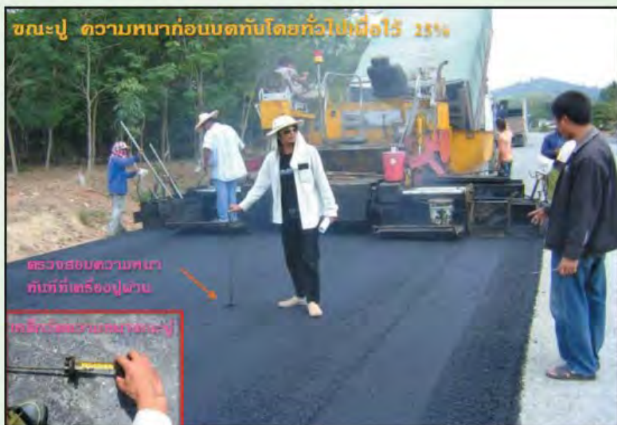
รูปที่ 6-30 แสดงการตรวจสอบความหนาของปูแอสฟัลต์คอนกรีต
