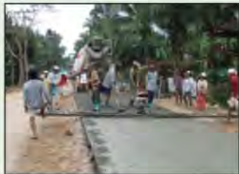
รูปที่ 6-58 ใช้ Front Screen ปาดแต่งผิวคอนกรีตให้เรียบ
