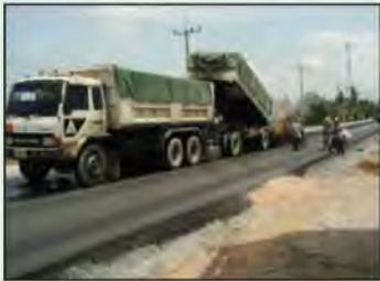
รูปที่ 6-27 รถบรรทุกส่วนผสมแอสฟัลต์คอนกรีต (Hot Mix) ต้องคลุมผ้าใบตลอดเวลา
