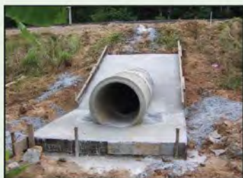
รูปที่ 5-40 กรณีแบบหล่อ (ด้านข้าง) สูงกว่าความหวดคอนกรีตที่เทอาจจะเป็นปัญหา ในการปาดแต่งผิวหน้าคอนกรีต
