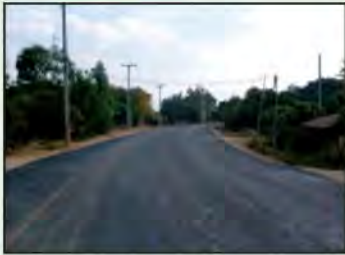
รูปที่ 6-8 ลักษณะผิวทางหลังการลาดยางรองพื้นแอสฟัลต์ (Prime Coat)
