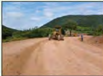
รูปที่ 4-36 การขุดตัววัสดุออกกรณีระดับก่อสร้างสูงกว่าแบบแปลน
