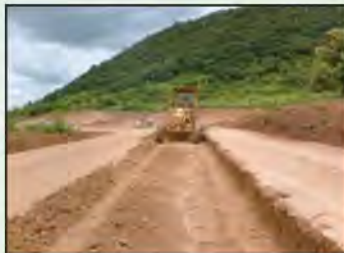
รูปที่ 4-44 ความแน่นไม่ผ่านเกณฑ์ และค่า O.M.C. ไม่อยู่ในช่วง \pm 3\% ให้รีดแล้วบดอัดใหม่
