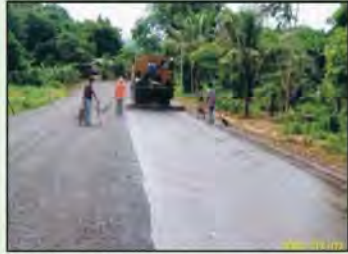
รูปที่ 6-44 การฉาบผิวสเลอรี่ซีล
