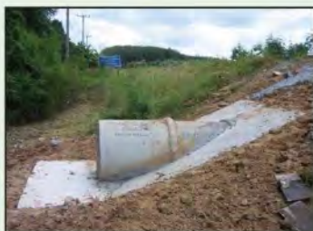
รูปที่ 5-41 หลังจากถอดแบบข้างแล้วให้ปรับดิน โดยรอบให้เสมอมิวนคอนกรีต
