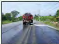
รูปที่ 6-25 จิตล้างทำความสะอาด ก่อนปูแอสฟัลต์
