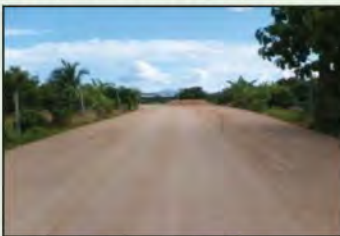
รูปที่ 4-24 งานชั้นดินถมคันทางที่ดำเนินการแล้ว เสร็จพร้อมที่จะก่อสร้างชั้นต่อไป
