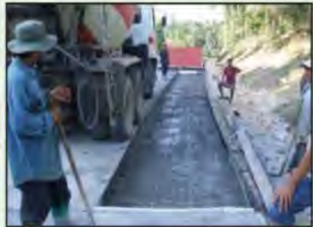
รูปที่ 6-57 เทคอนกรีตปรับเกลี่ยพร้อมวางเหล็กตะแกรงก่อนเทคอนกรีตทับบนเหล็ก
