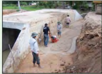
รูปที่ 4-21 การบดอัดความแน่นบริเวณ ด้านข้างท่อเหลี่ยม
