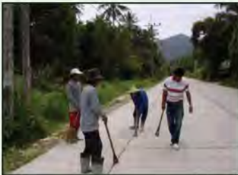
รูปที่ 6-66 กวาด ทำความสะอาด หรือใช้ลมเป่ารอยต่อ ก่อนหยุดเทยาง
