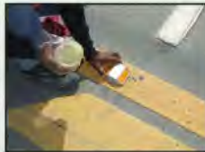
รูปที่ 7-6 รูปแสดงการติดตั้งหลอดสะท้อนแสง
