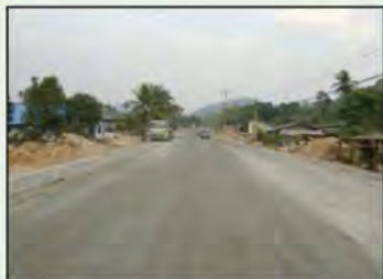
รูปที่ 4-50 ชั้นพื้นทางที่ก่อสร้างแล้วเสร็จ และยังไม่มีพรมโคทต้องฉีดพ่นน้ำหล่อเลี้ยงผิวหน้าเพื่อรักษาความชื้น
