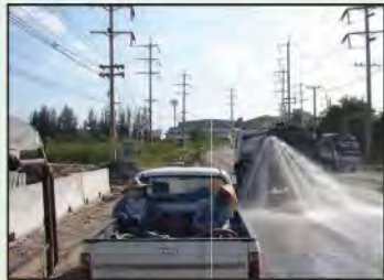
รูปที่ 8-10 การฉีดพ่นน้ำลงบนพื้นที่ก่อสร้างเพื่อลดผลกระทบจากผุ่นละออง
