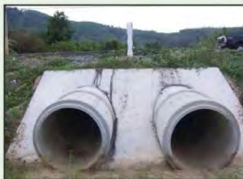
รูปที่ 5-42 หลังจากถอดแบบและปรับระดับดินรอบแผ่นคอนกรีตเรียบร้อยแล้ว ให้ตรวจสอบ เพื่อให้แน่ใจว่าไม่มีกรัดเซาะของน้ำรอบบริเวณแผ่นคอนกรีต
