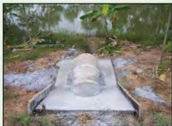
รูปที่ 5-42 หลังจากถอดแบบและปรับระดับดินรอบแผ่นคอนกรีตเรียบร้อยแล้ว ให้ตรวจสอบ เพื่อให้แน่ใจว่าไม่มีกรัดเซาะของน้ำรอบบริเวณแผ่นคอนกรีต
