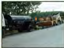
รูปที่ 6-41 จิตพื้นยางก่อนโรยหินตามแล้วบดอัด
