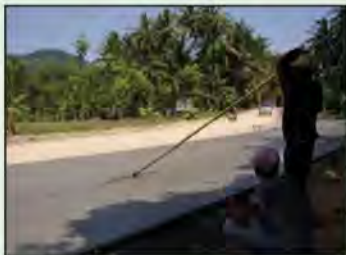
รูปที่ 6-60 แต่งสายที่ผิวหน้าขณะคอนกรีตยังหมาดอยู่
