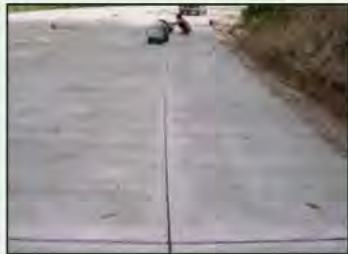
รูปที่ 6-66 กวาด ทำความสะอาด หรือใช้ลมเป่ารอยต่อ ก่อนหยุดเทยาง
