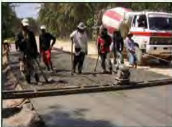
รูปที่ 6-58 ใช้ Front Screen ปาดแต่งผิวคอนกรีตให้เรียบ
