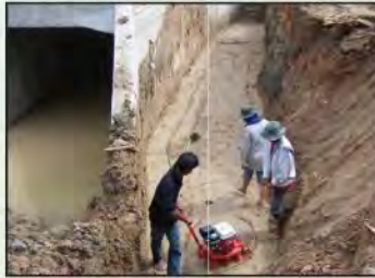
รูปที่ 5-32 การติดตั้งถังท้อเหลี่ยม
