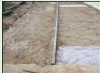
รูปที่ 6-53 แบบตั้งยึดอย่างแข็งแรง
