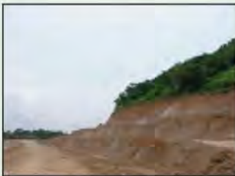
รูปที่ 4-27 การขุดตัด Back Slope ที่สูงมาก ๆ ให้ได้แบบมีชันพัก
