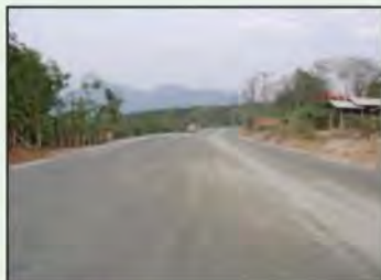
รูปที่ 4-50 ชั้นพื้นทางที่ก่อสร้างแล้วเสร็จ และยังไม่มีพรมโคทต้องฉีดพ่นน้ำหล่อเลี้ยงผิวหน้าเพื่อรักษาความชื้น
