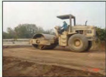
รูปที่ 4-23 การบดอัดบริเวณที่อยู่ใกล้กับโครงสร้าง คสล. ไม่ควรสิ้นสะท้อนเนื่องจากจะทำให้โครงสร้างเสียหายได้
