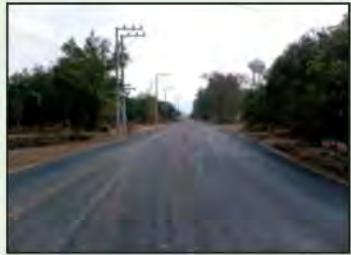
รูปที่ 6-8 ลักษณะผิวทางหลังการลาดยางรองพื้นแอสฟัลต์ (Prime Coat)
