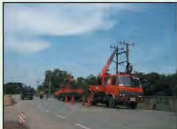
รูปที่ ๒ - ๒ การดำเนินการย้ายเสาตามูปโคกออกจากเขตก่อสร้าง
